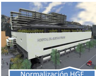
Normalización HGF Etapa 1 Avance Físico 50,53%
